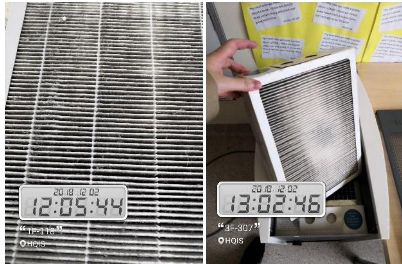
图 14-15. 净化器内的滤网需要根据生产商的建议进行定期更换
