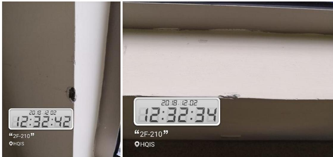
图 21-22. 墙上涂料脱落可能会导致墙体释放出颗粒物，并导致室内 PM 浓度上升
